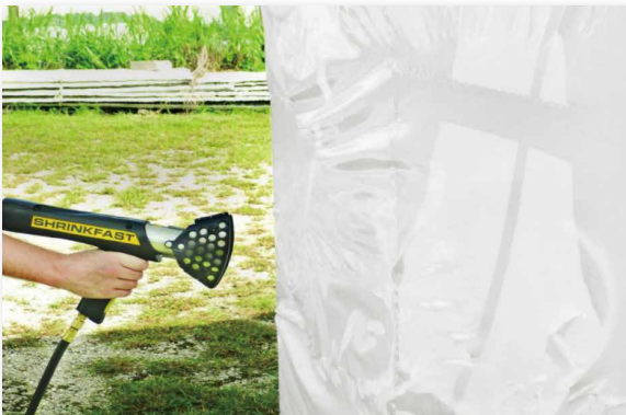
専用ヒートガンにて加熱し溶着・収縮し 張りと強度のあるきれいな仕上がりに。
