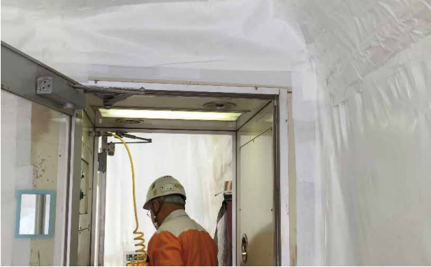
出入りにエアシャワー付き集塵機を設置
