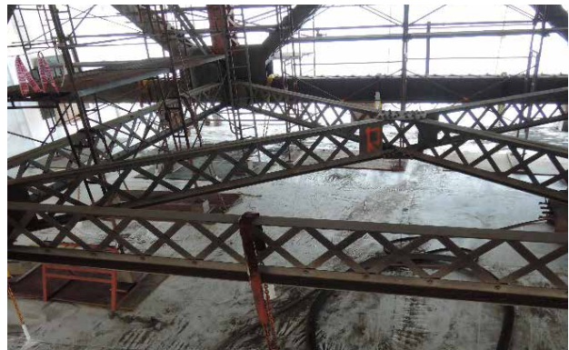
ブラスト後の足場内部～床の養生はシートがすべて 圧着されている為汚染物の漏洩が無い *クイックデッキにて使用
